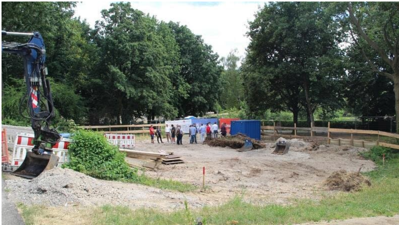
Arbeiten haben begonnen: Auf diesem Grundstück an der Ooser Bahnhofstraße entsteht das Apartmenthaus für die Lebenshilfe. Foto: Henning Zorn
