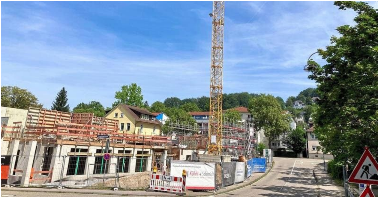
An der Murgstraße entstehen in einem Neubau der Baden-Badener Stadtbaugesellschaft GSE 54 neue Wohneinheiten. Dazu kommen drei Gewerbeeinheiten. Foto: Harald Holzmann
