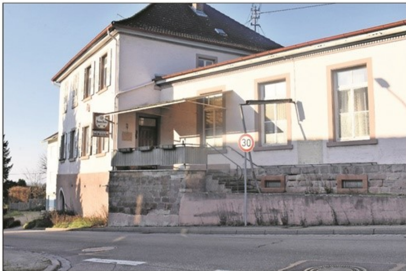
Das historische Gebäude „Gasthaus Fremersberg“ in Varnhalt wird seitens der stadt-eigenen Entwicklungsgesellschaft als Kulturdenkmal erhalten.
