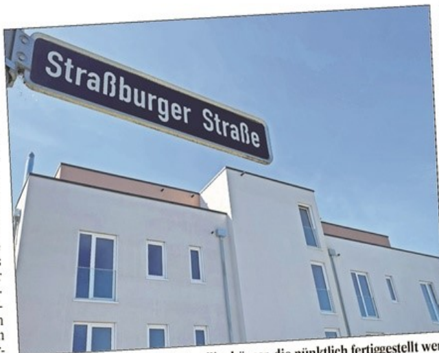
Eines der beiden neuen Mehrfamilienhäuser, die pünktlich fertiggestellt wer- den konnten, steht in der Straßburger Straße in der Cité. Fotos: Stephan Friedrich
