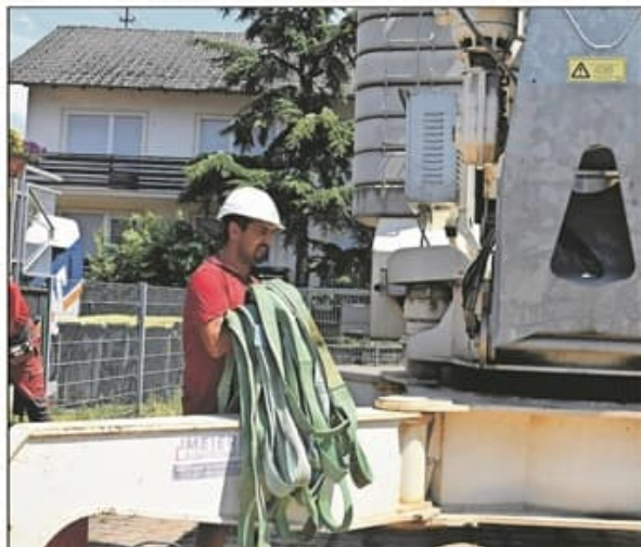
Es geht los: Derzeit richten die Arbeiter die Baustelle noch mit Absperrgittern und Sicherungsgurten ein.
