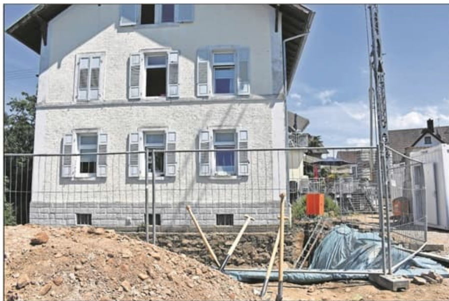
Der Baukran steht schon: Diese Ansicht wird sich mit dem Erweiterungsbau, der im Juli 2023 fertiggestellt sein soll, gravierend ändern.
