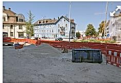
Blick vom Babo-Hochhaus auf den neu entstandenen Kreisverkehr.
