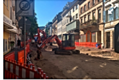
Baggerarbeiten in der Lichtentaler Straße.
